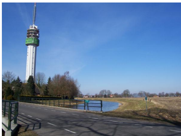
Hoge Brug tot 500 meter westelijk
