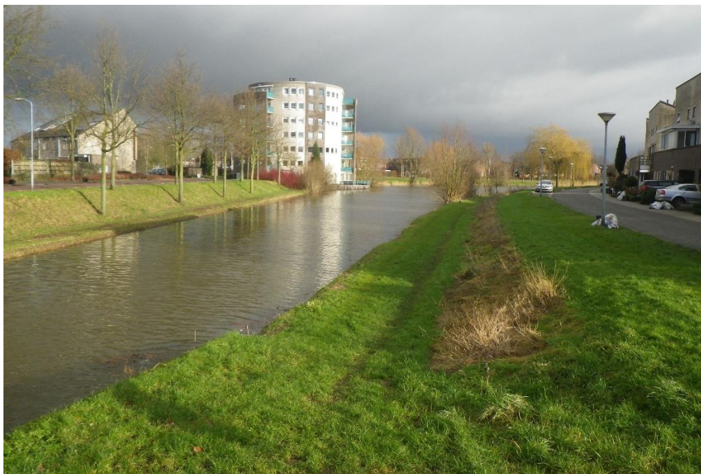
Meerdere wateren in De Leesten zijn door het maaipad onderaan het talud niet bereikbaar in de winter met de bus en een aanhanger (foto zomer 2017).
