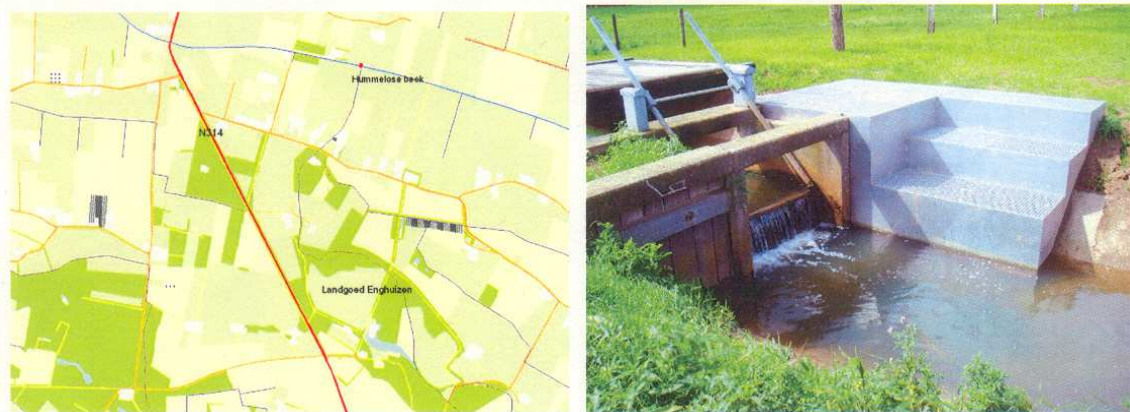
Figuur 2.9 Vertical slot Hummelose beek
