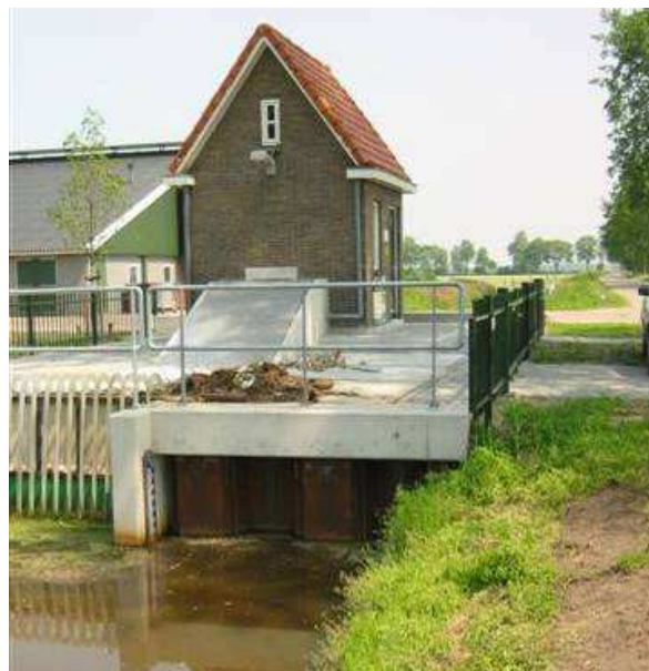
Locatie 6, gemaal Dekkersland
