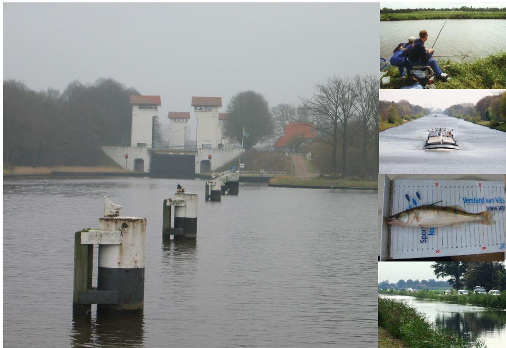
Naar aanleiding van Verruiming Twentekanalen – Fase 2, april 2014
