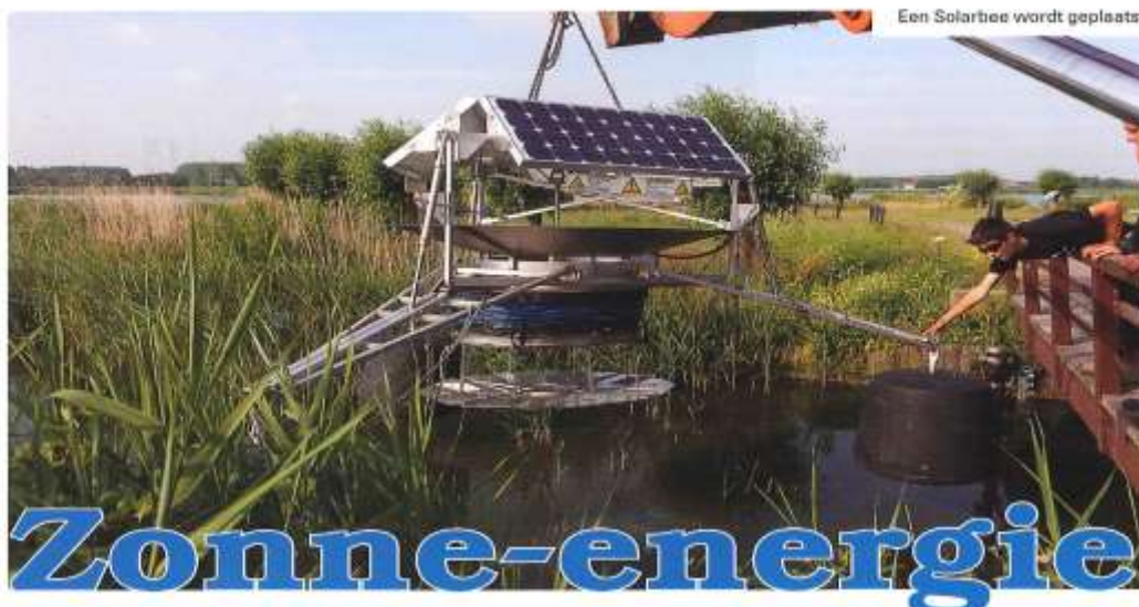
Een SolarBee wordt geplaatst.
